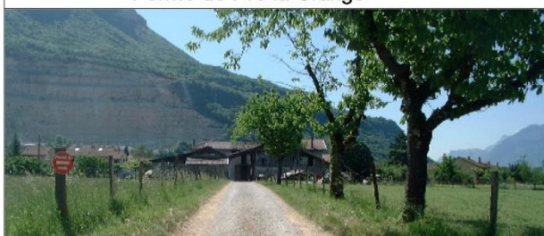
Ferme de Pré la Grange
