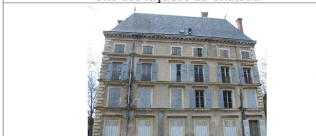
Une des façades du Château
