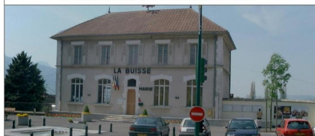
La Mairie actuelle construite en 1888
